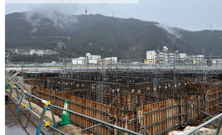
④工区（敷地北西面より撮影） 型枠・配筋工事
