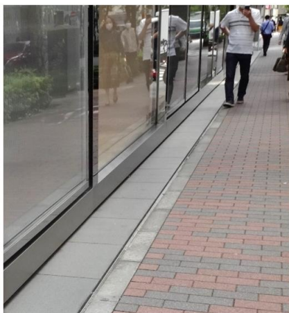
歩道と段差のない壁面後退区域
