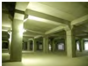
大州雨水貯留池
