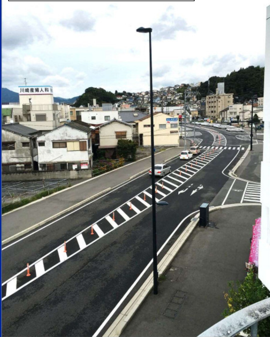
8工区(暫定道路整備状況)
