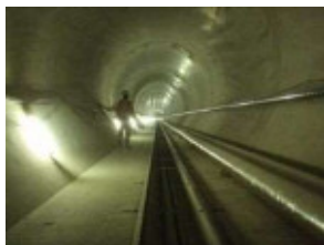
雨水幹線 (千田雨水1号幹線)
