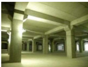
大州雨水貯留池
