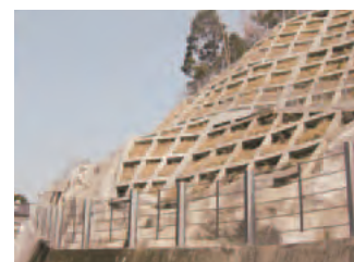
急傾斜地崩壊対策事業
