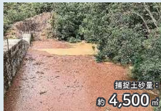
土石流発生直後 (R3.8.15 撮影)
