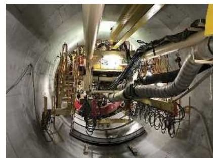
雨水渠工事の様子
