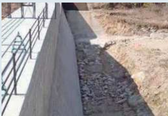
土石流発生前 (H29.3.9 撮影)
