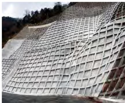
写真 資 5-4 のり枠工の例
