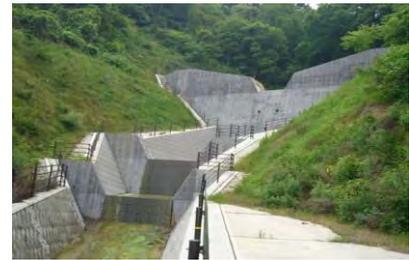
写真 資 5-1 砂防堰堤
