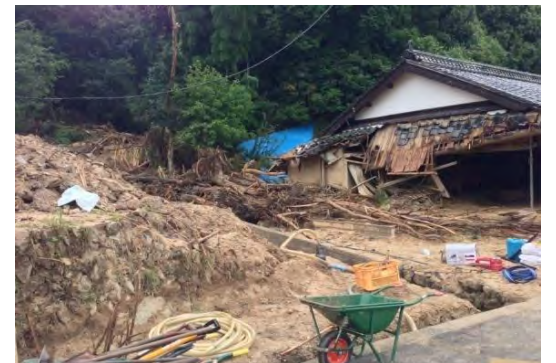
写真 5-15 大林町代田地区の被災家屋
