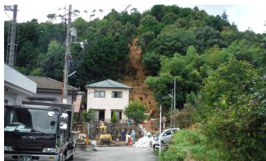
写真 5-7 可部東二丁目付近
