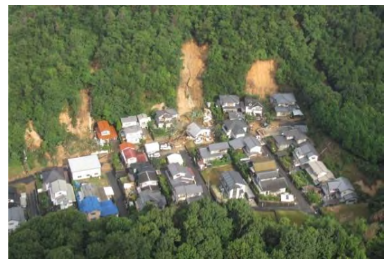
写真 5-13 可部町桐原地区梢台団地周辺
