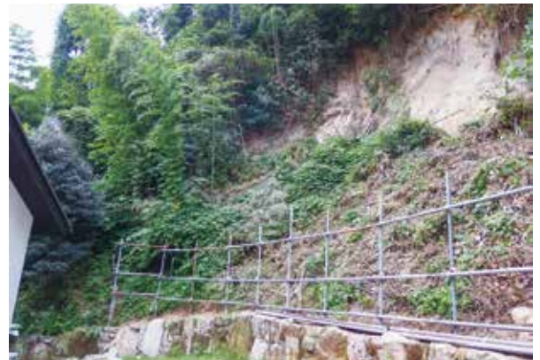
急傾斜地崩壊対策事業(対策前)
