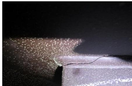
写真 1 鋼製橋脚内部梁上フランジの塗膜割れ
