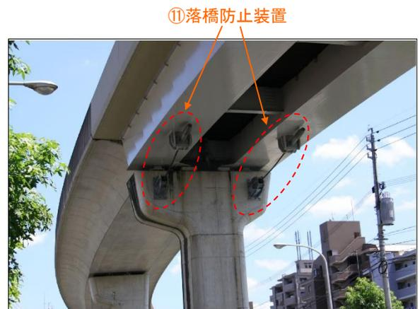
[参考図5] 落橋防止装置
