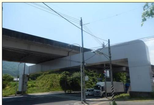
例) 交差点内で、中央分離帯内に橋脚設置スペースが確保できない場合(鋼製門型橋脚構造で対応)
