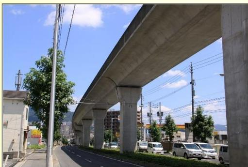
例) 中央分離帯内に橋脚設置(標準的な橋脚形状)
