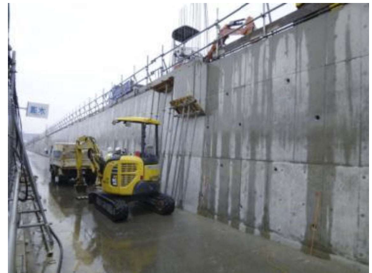
生活道路側から見た写真
