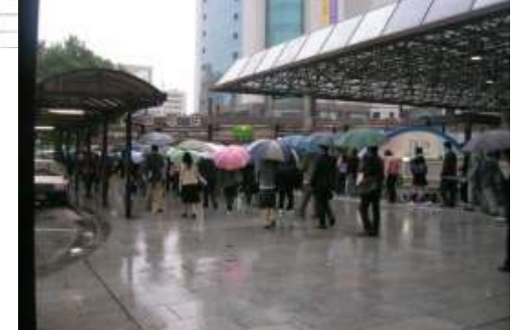
歩行者動線に合わせ連続していない屋根
