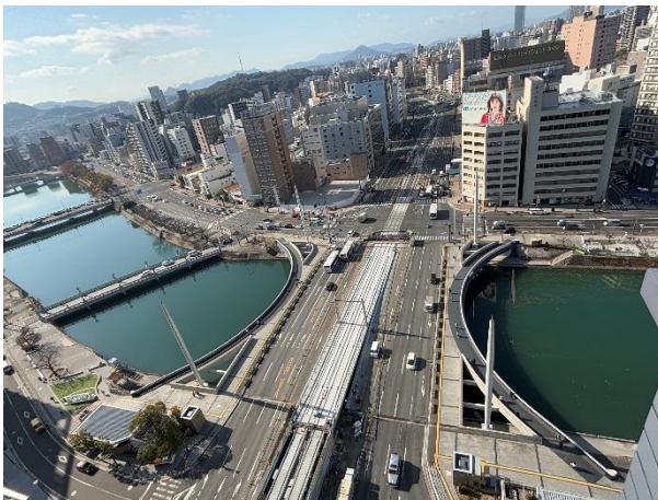
軌道新設工事
