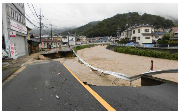
図-10 平成 30 年 7 月豪雨における被災状況
