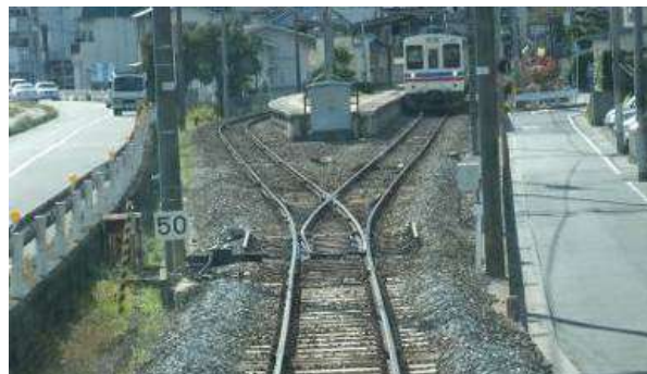
図-48 行き違い設備の例（三滝駅）
