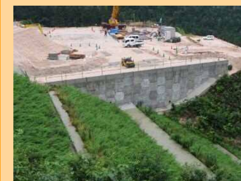
⑬補強土壁工
