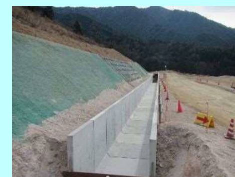
⑤南側バイパス水路
