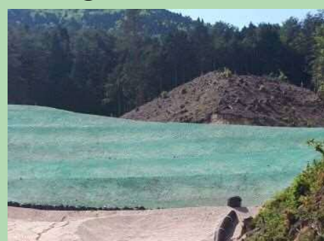
⑦クリコート(仮設)
