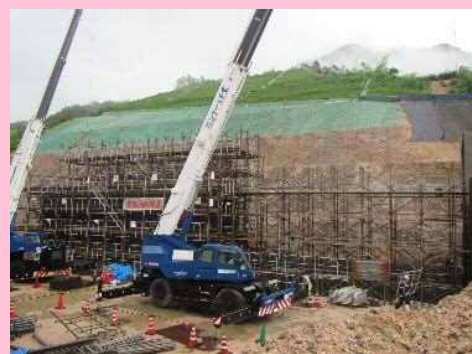
②C・Dブロック(足場組立)
