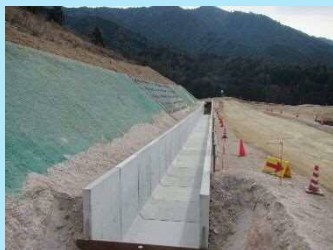
南側バイパス水路
