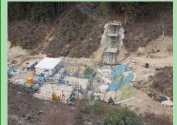
モルタル注入(カーテングラウト)
