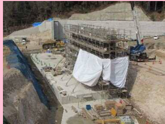
②Qブロック(型枠組立)
