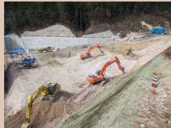
⑥防災調整池 掘削
