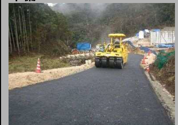
⑬工事用道路工
