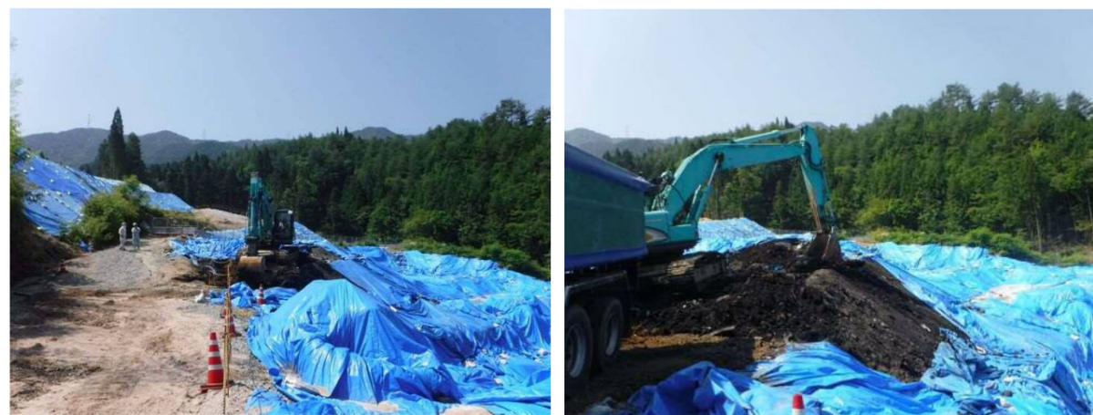
現在、埋立判定基準内の燃え殻の撤去作業を行っており、掘削にあたっては、一時的にシートをはがして掘削し、搬出にあたっては、飛散防止対策及び漏水対策として蓋付きの水密ダンプで搬出しています。
