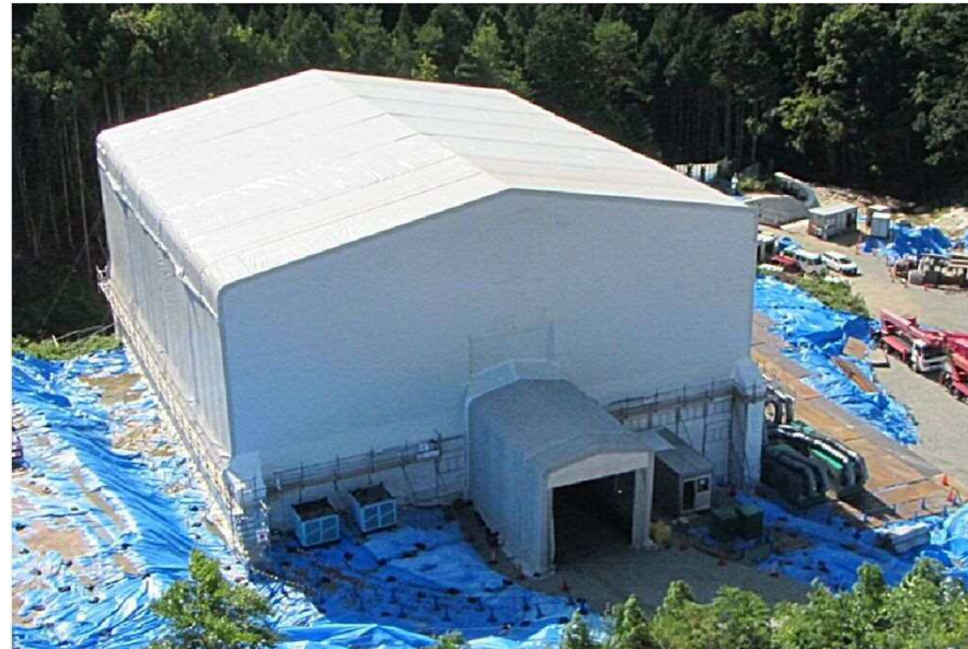
《掘削用テント》
