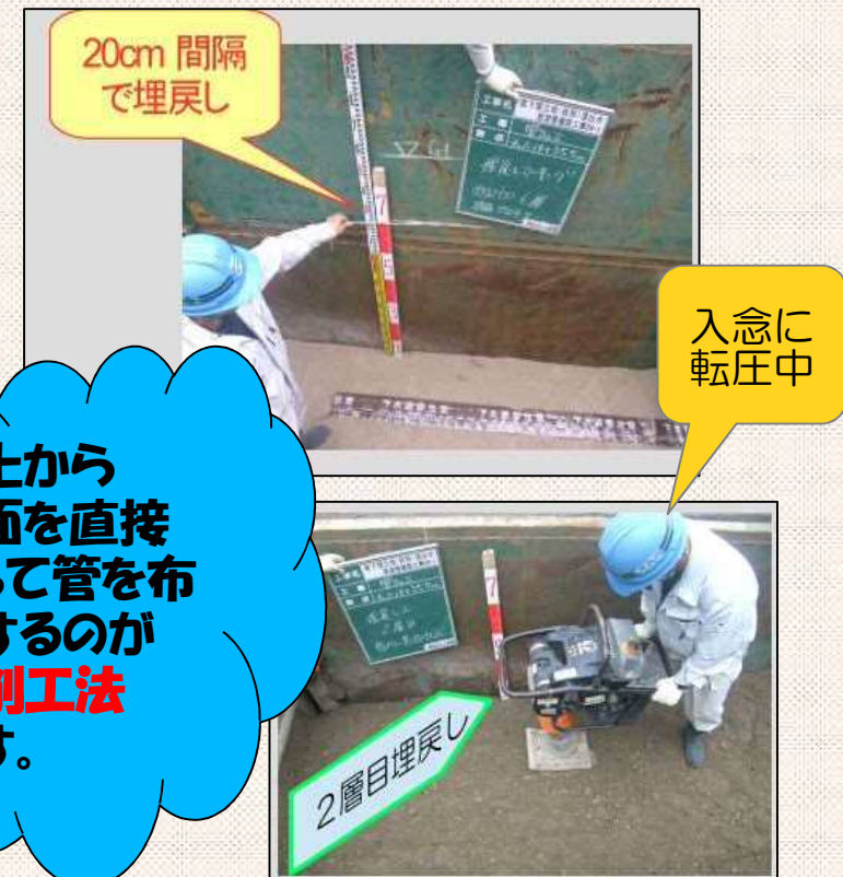
■再生砕石による埋戻し作業状況例
