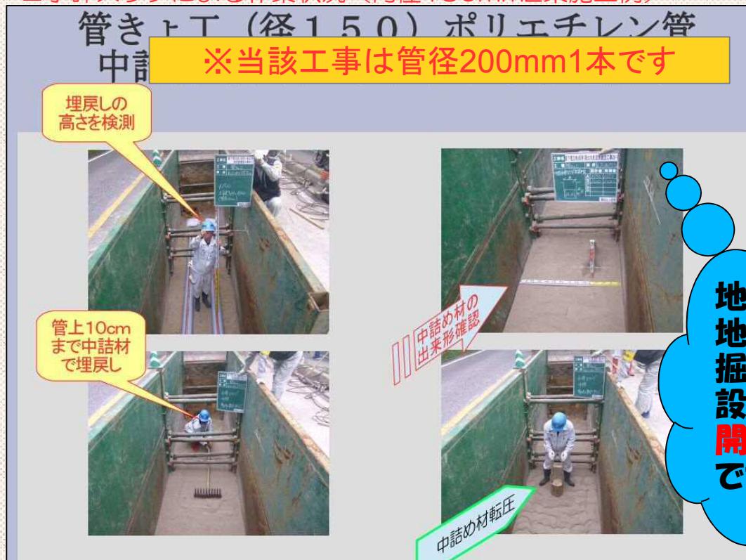
■水砕スラグによる作業状況（内径150mm2条施工例）
