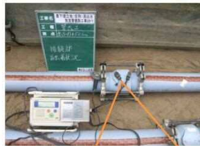
管接続、融着状況
