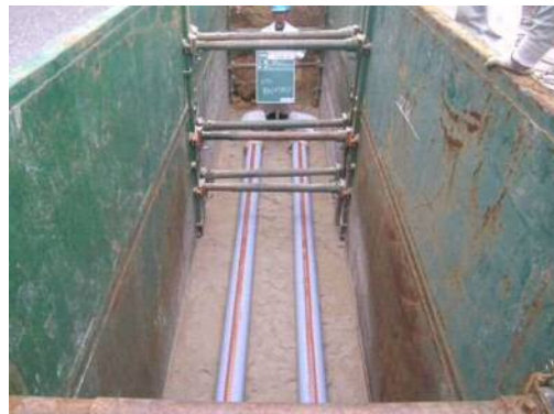
管路及びマンホール設置
