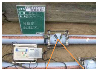
管接続、融着状況
