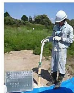
写真-2 水中ポンプの挿入状況
