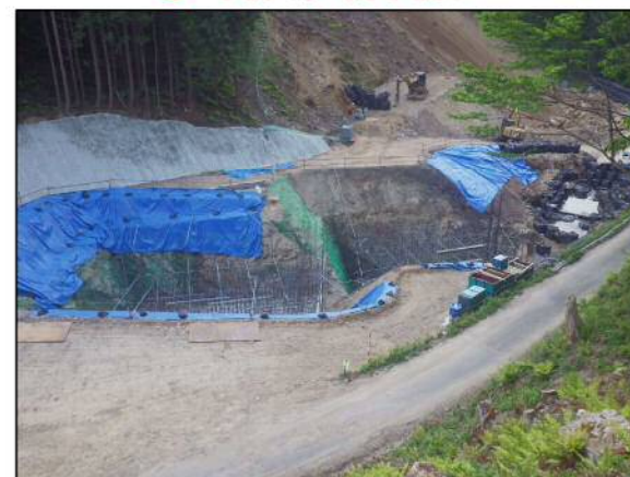
⑤3号橋・第1橋梁橋台工
