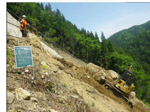
②法面工（高所掘削）
