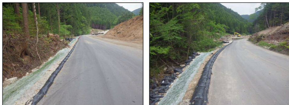
作業用道路工
