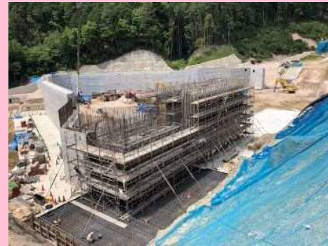
②ABブロック(型枠組立)
