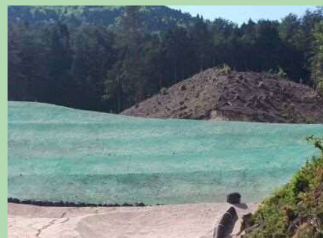
⑦クリコート(仮設)
