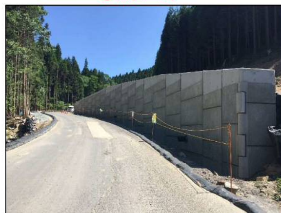
④補強土壁工
