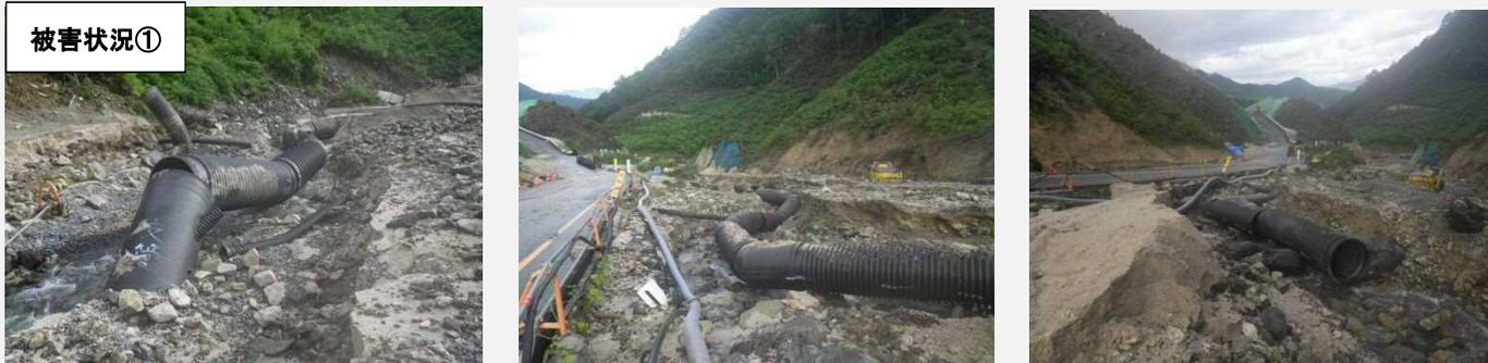
完成形では、盛土等により地下へ埋設される集排水管が、工事途中での豪雨により管周りの砕石が洗掘され管が露出し、継手が外れるなどした。
