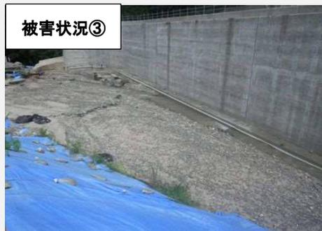
施工中の防災調整池へ土砂が流入し掘削面の土砂が洗われた。
