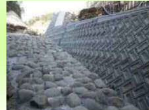
④ブロック積工
