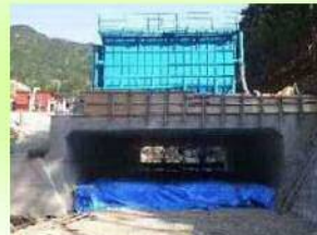
③ボックスカルバート工
