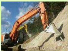
①防災調整池部の法面掘削
