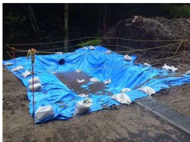
仮設沈砂池設置
