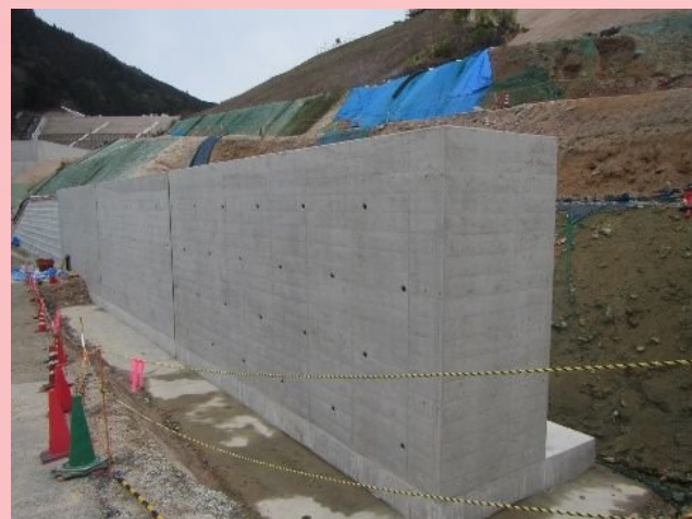
⑦ 現場打L型擁壁
