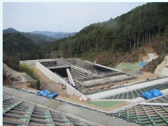
⑤ 浸出水調整池全景
