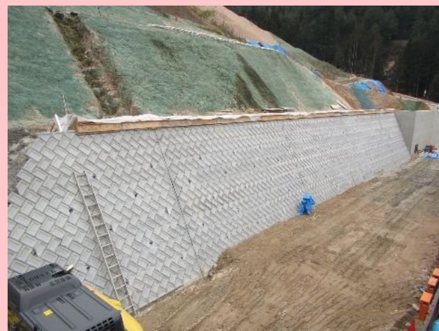
⑧ ブロック積擁壁
