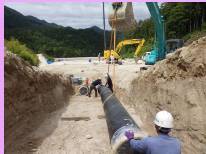
ポリエチレン管敷設状況
