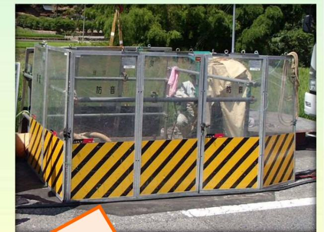
作業で発生する騒音を低減するため、立坑 (たて穴) の周囲に防音パネルを設置しました。
