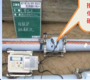
接合部は電熱によって融着・接合するEF接合方式を採用しており、接合部が強固に一体化でき、高い水密性を確保しています。
