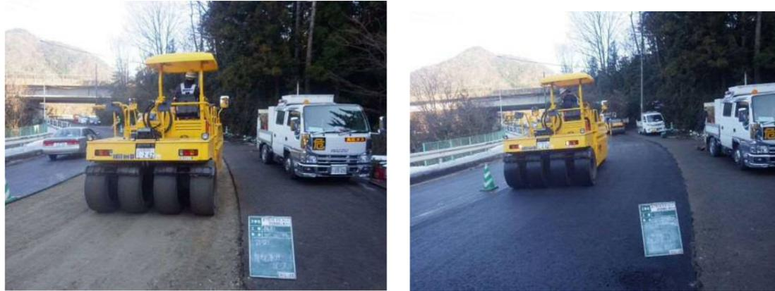
舗装が傷んでいたため、安佐北区役所地域整備課との合併施工により、放流管を布設する側だけでなく道路全面の舗装を新しくしました。
