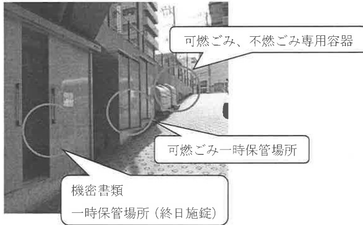
写真① 地下スロープ ごみ保管場所
