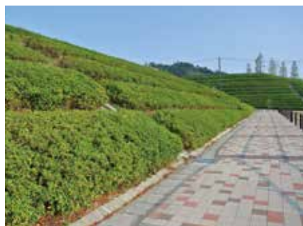
法面を緑化して周辺景観と調和した例
