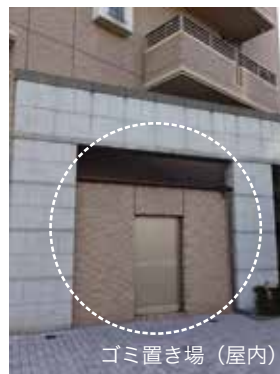
屋内にゴミ置き場を設けた例
