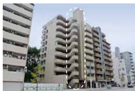
建築物と同じ構造の屋外階段の例
