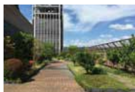
屋上緑化の例
