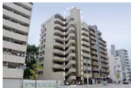
建築物と同じ構造の屋外階段の例
