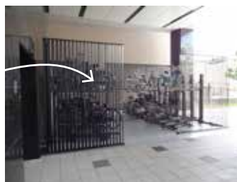
駐輪場をルーバーで目隠ししている例
