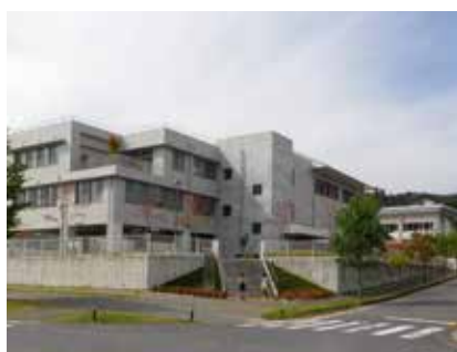
中心となる施設の例（公民館）
