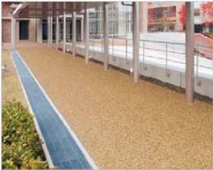
施工イメージ
