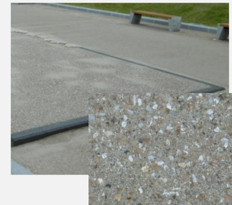
骨材（碎石）を加えた脱色アスファルト舗装
