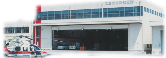
【広島市消防航空隊基地】
