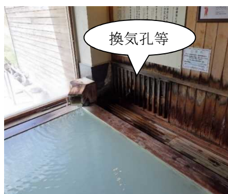
図5 温泉注入口付近に設置された換気孔等
