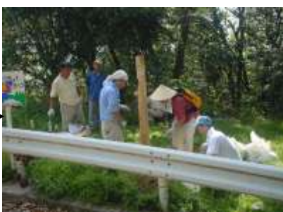
設置について検討する作業
