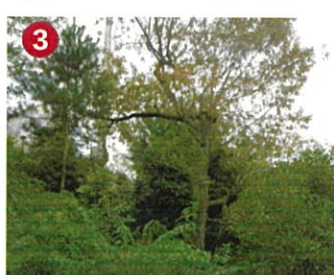
崖に枯れ木 崩れる恐れ
