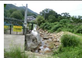
白滝川上流災害現場
