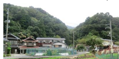
土石流の発生危険のある谷
