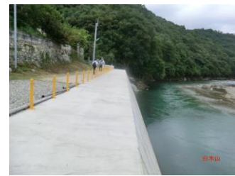
護岸の改修後（R3.9）
