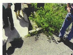
水路が直角であふれて浸水
