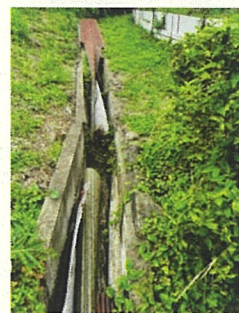
水が地下を流れ石垣から噴水
