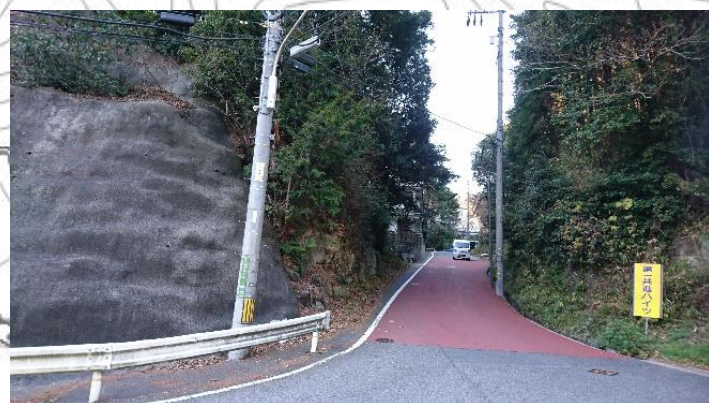
③地震・豪雨で両側の崖が危険な 第一共進ハイツ入り口
