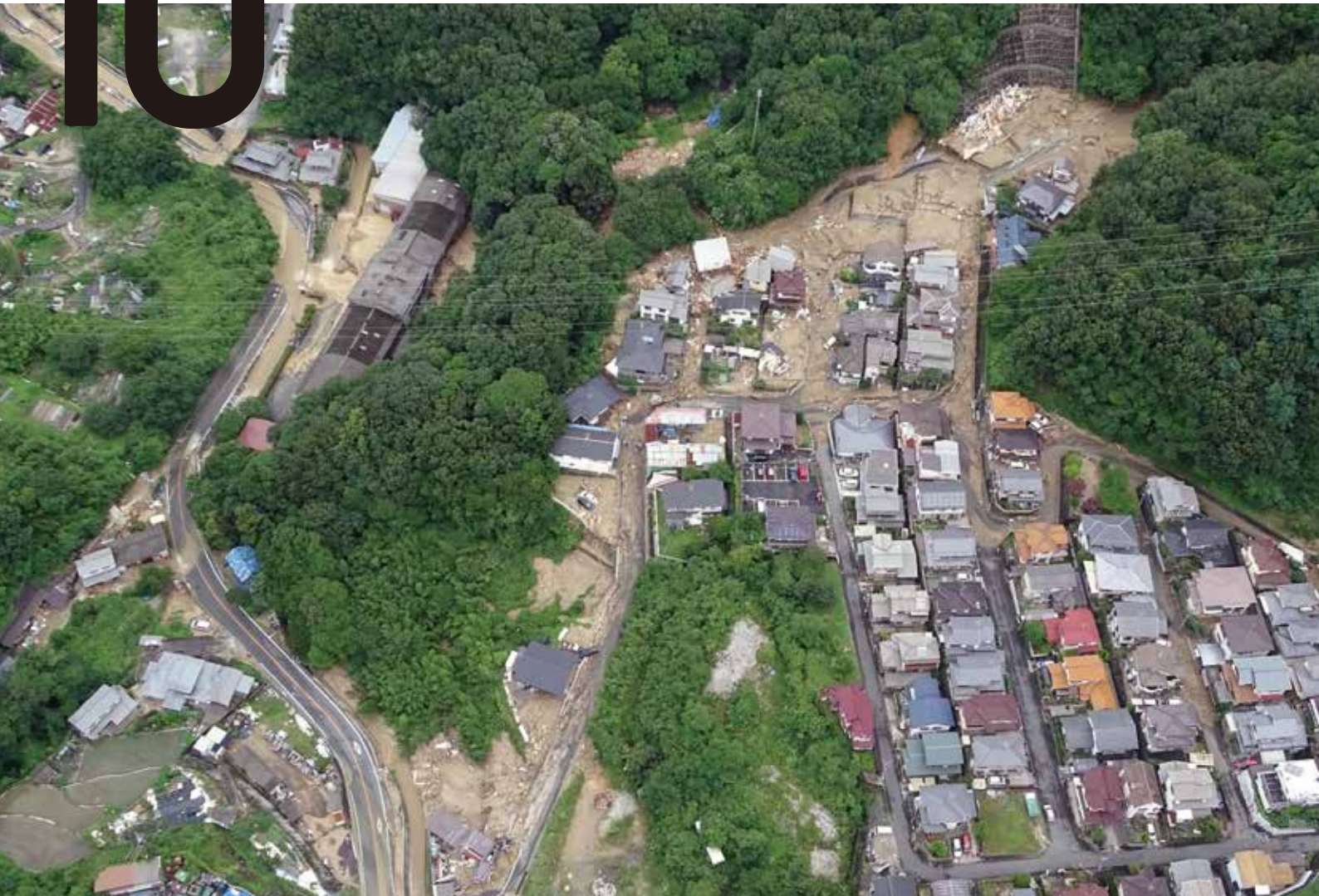
安芸区矢野東の被災地(梅河団地)
