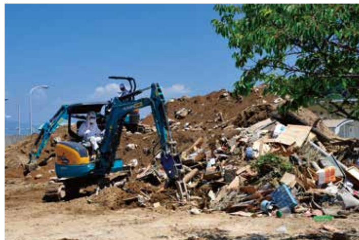
復旧作業の様子(似島)
