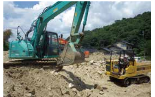
民有地土砂撤去の作業状況
