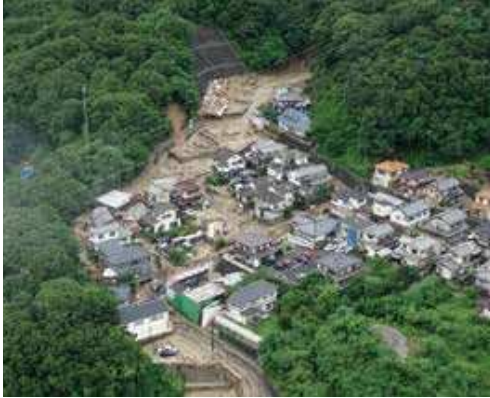
安芸区矢野東の土石流
