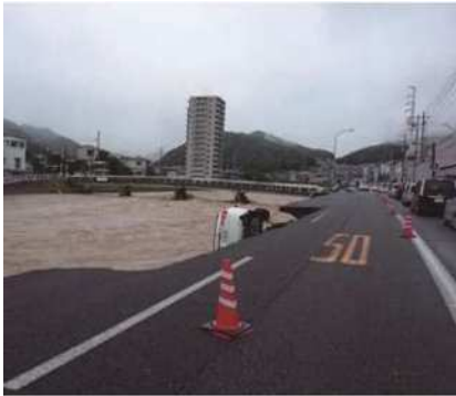
図-5 国道 2 号の道路流出
