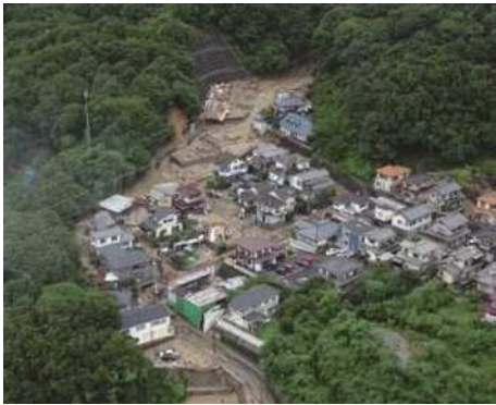
図-4 安芸区矢野東の土石流
